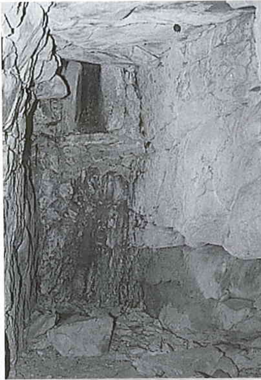
Ventaniña en el muro oriental de la celda. Su base ha sido uno de los objetivos de la consolidación realizada.
