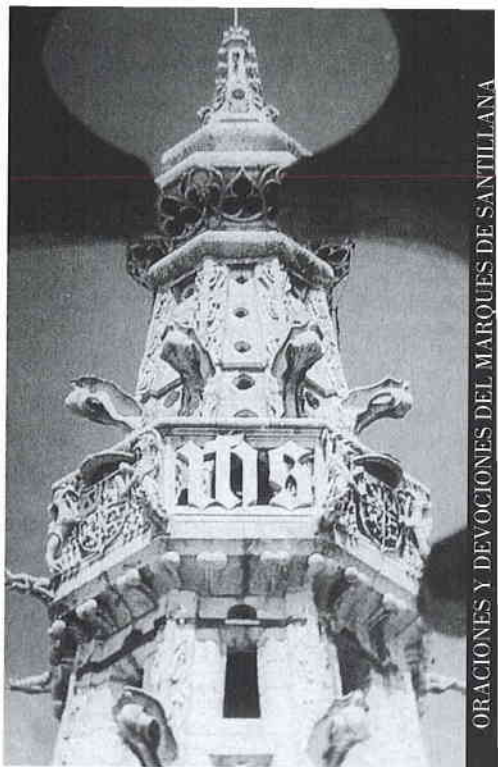
Balcón de la torre norte de la catedral de Burgos a los cuatro vientos. Obra de Juan de Colonia (1442-1458).
