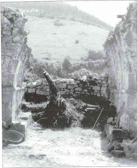
Lám. IV, 1. Detalle de la cabecera de la ermita de S. Pedro de Caviedes, en momentos próximos a la retirada de escombros.
