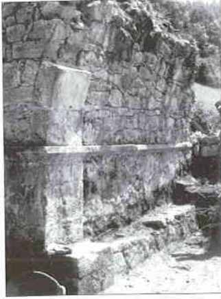
Lám. IV, 3 Detalle del muro e inicio de la bóveda de la cabecera.
